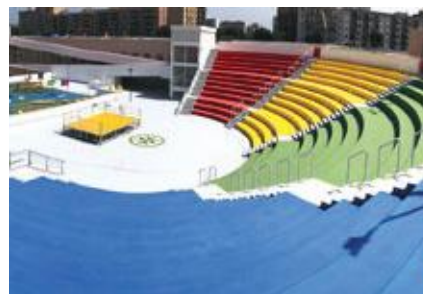
Impermeabilizzazione su gradinate in cemento Ipercoop di Bari
