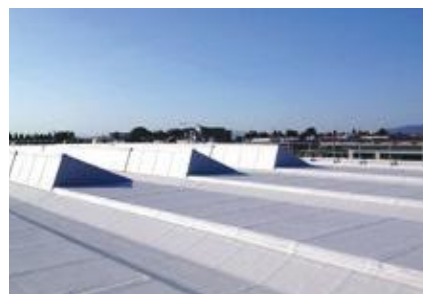
Impermeabilizzazione guaina liscia e ardesiata. Capannone industriale Pisa
