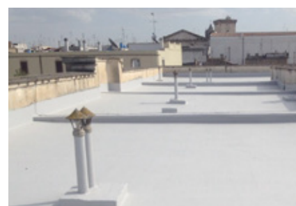
Supporto finito, coibentato e impermeabilizzato.
