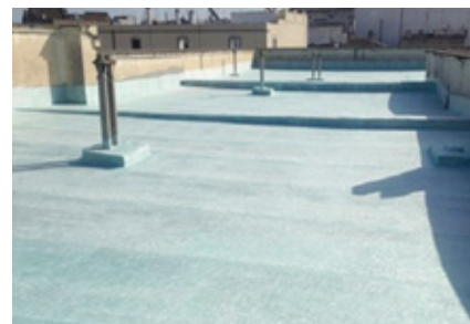
Impregnazione completata con il sistema Tecnogum.
